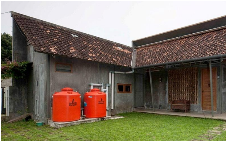
Gambar 1.2 Desain sederhana panen air hujan (Sumber: Dafamland.com)
